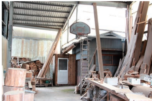
写真4：増築部分。奥の事務所と便所は木造。
