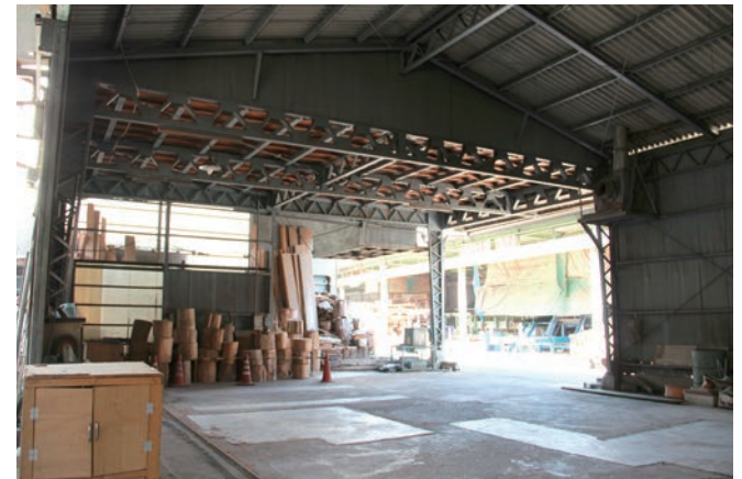
写真2：メイン工場内。反対側から。
