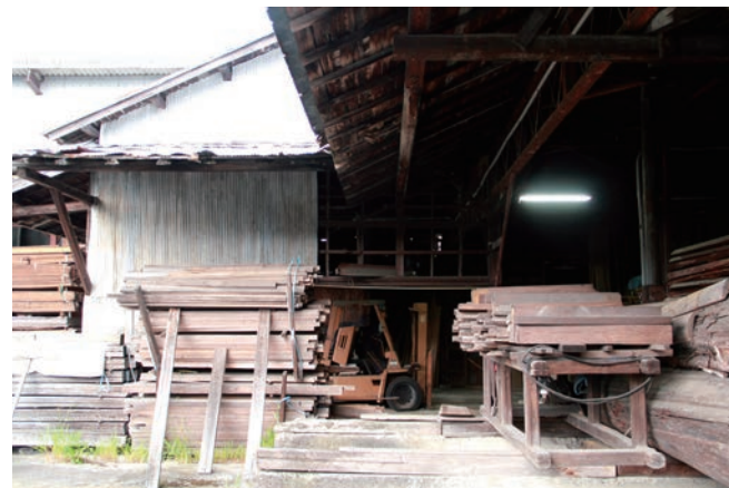
写真2：左側は鉄骨造の倉庫。右側は木造倉庫です。
