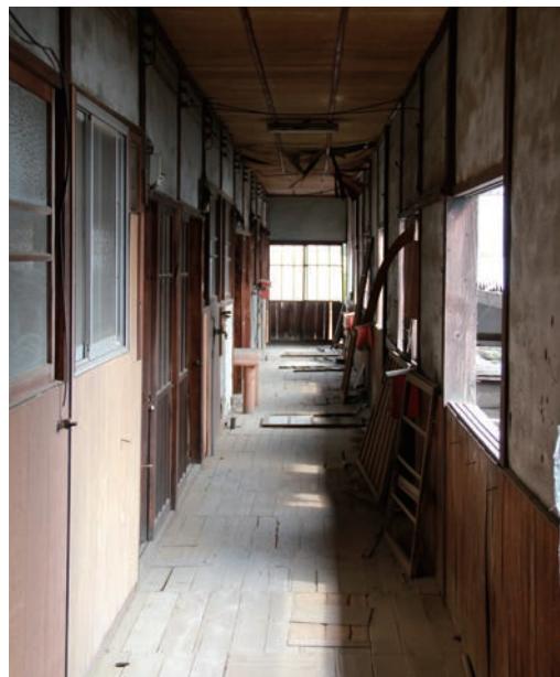
写真6：共有廊下部分から全個室を見る。
