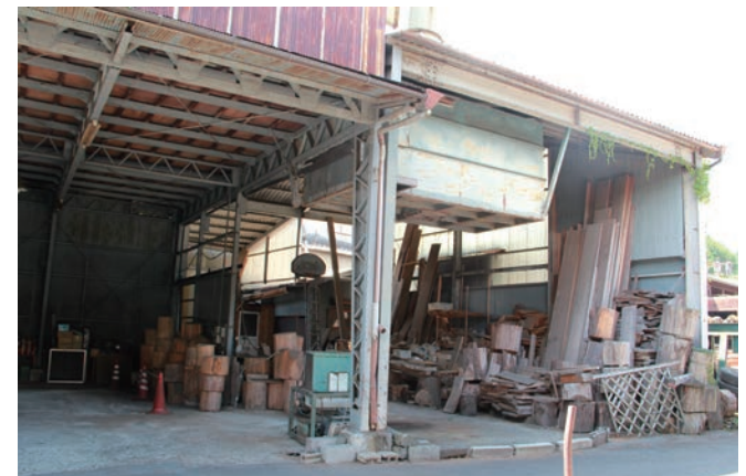
写真3：メイン工場と増築部分。
