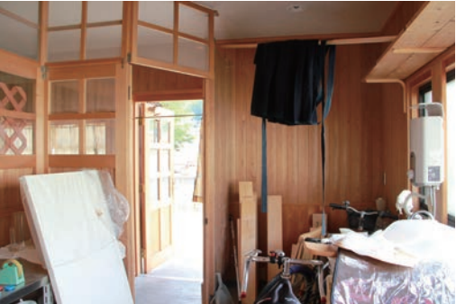
写真 6：給湯器あり。手洗い、シンクあり。
