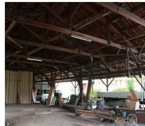
写真2：天井の木組みが印象的な建物です。
