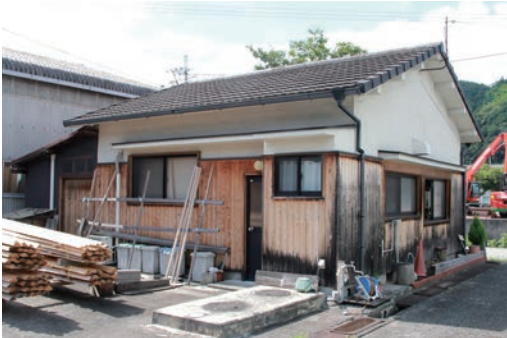
写真 7：勝手口方向より建物を見る。
